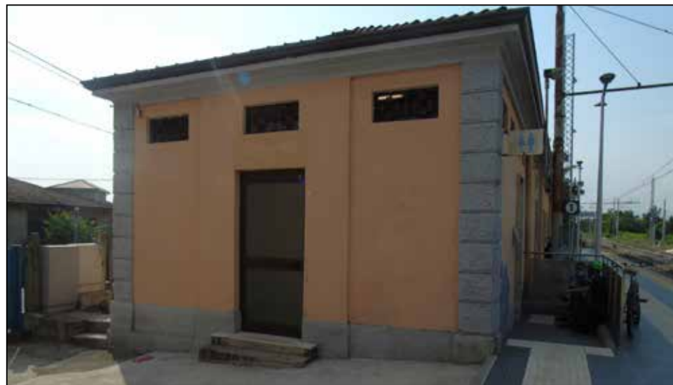
Servizi igienici chiusi alla stazione di Palazzolo. Una situazione inammissibile
