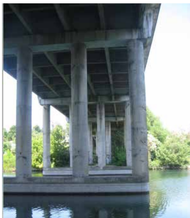
Il vecchio ponte in Viale Europa
