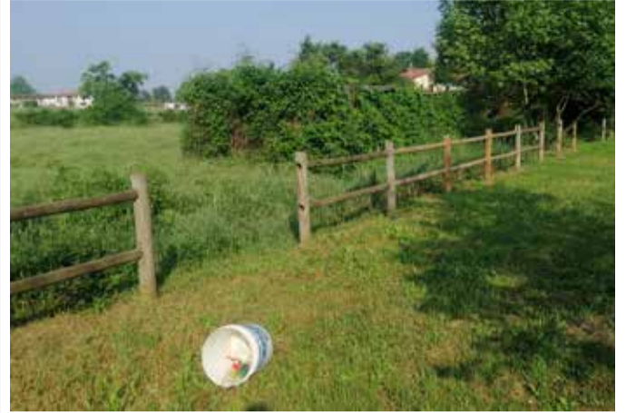
Nel bel parco di via Merisi manca buona parte della staccionata di recinzione
