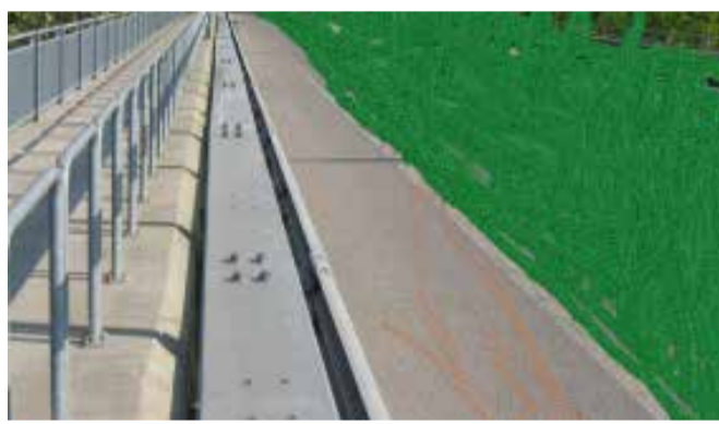
La trasformazione del ponte di viale Europa in giardino
