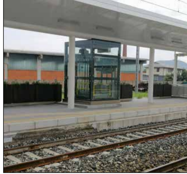
Da anni gli ascensori alla stazione della linea ferroviaria Brescia Bergamo sono fermi
