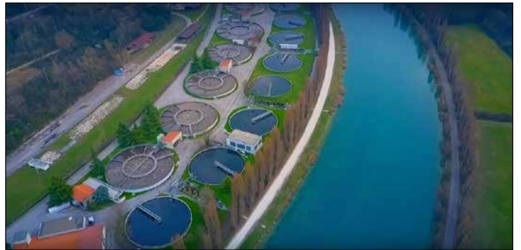
Il depuratore del Garda
