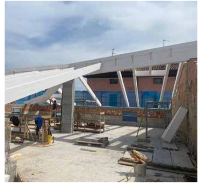
I lavori sull'edificio storico
