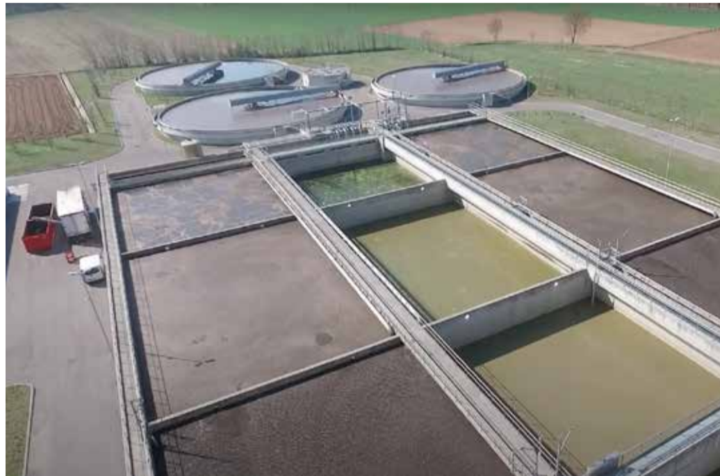
il nuovo depuratore Bassa Franciacorta di Rovato
