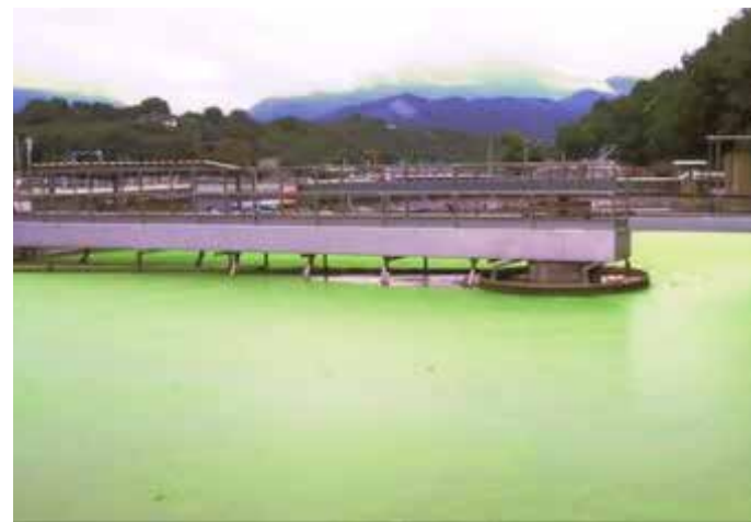
il depuratore di Paratico
