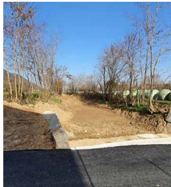
Il torrente Carera dopo le operazioni di pulizia e di rifacimento dell'alveo e degli argini
