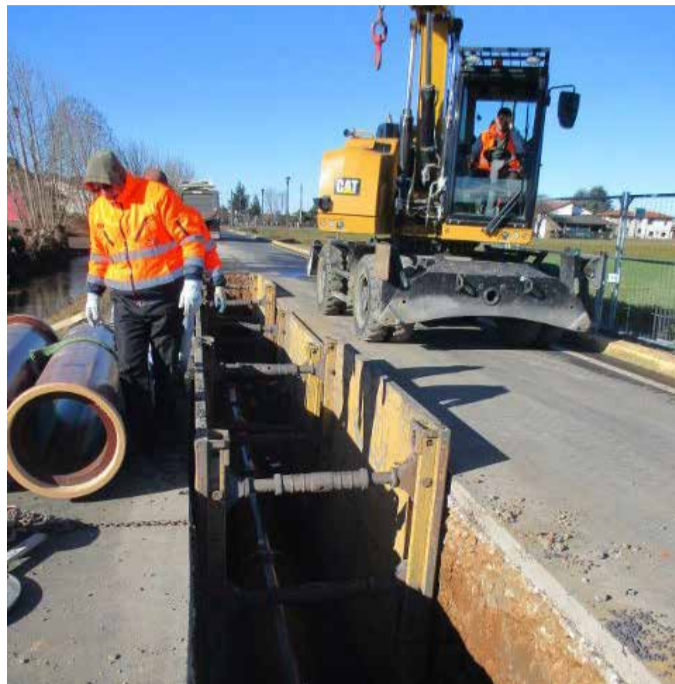
I lavori alla rete fognaria
