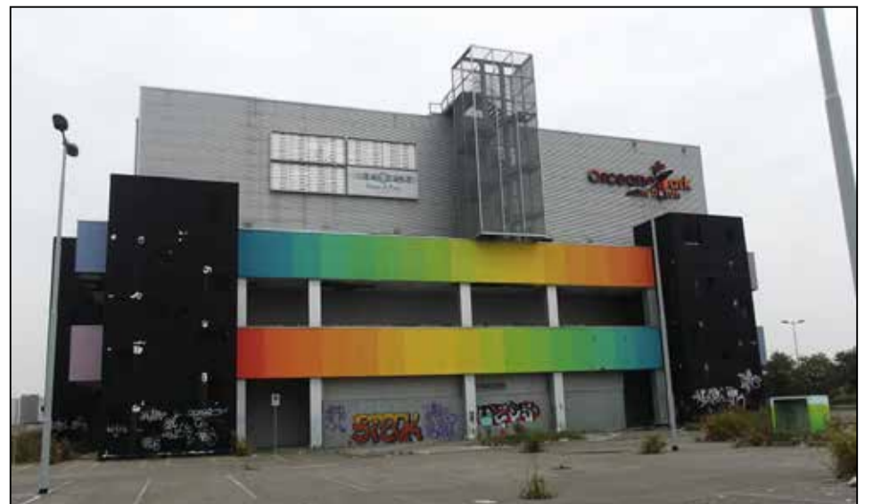
Degrado e vandalismo per il complesso commerciale abbandonato di via Lombardia
