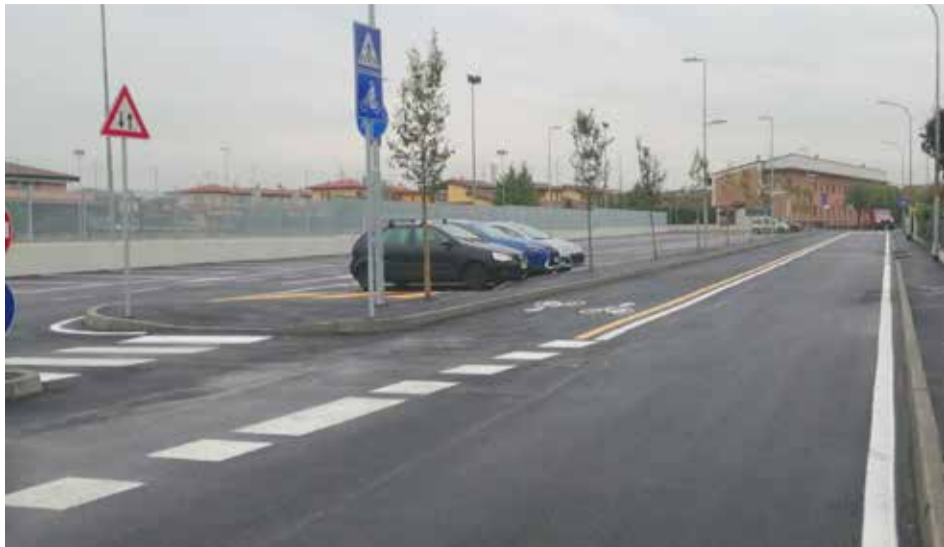
TRAVAGLIATO: l'asfaltatura e la pista ciclabile di via Mazzini
