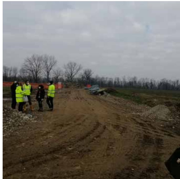
L'area dei lavori
