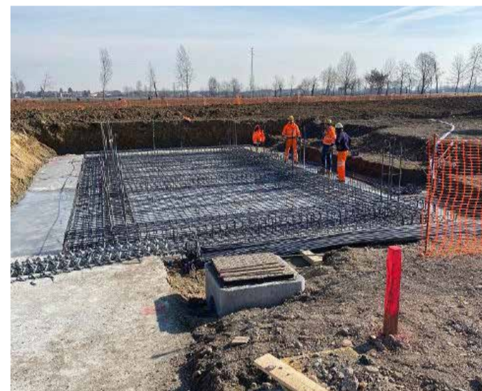
Il cantiere di Mairano
