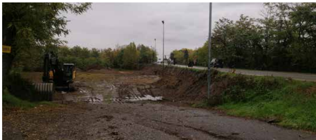
I lavori della ciclopedonale di via Brescia
