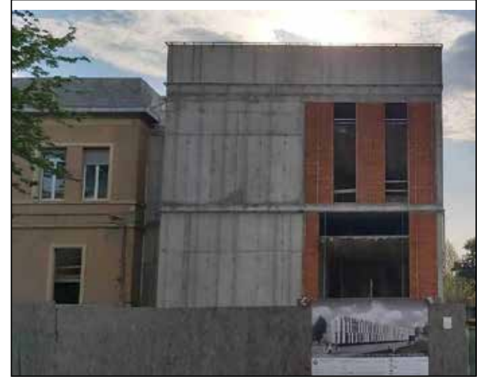
Il cantiere della scuola fermo da due anni
