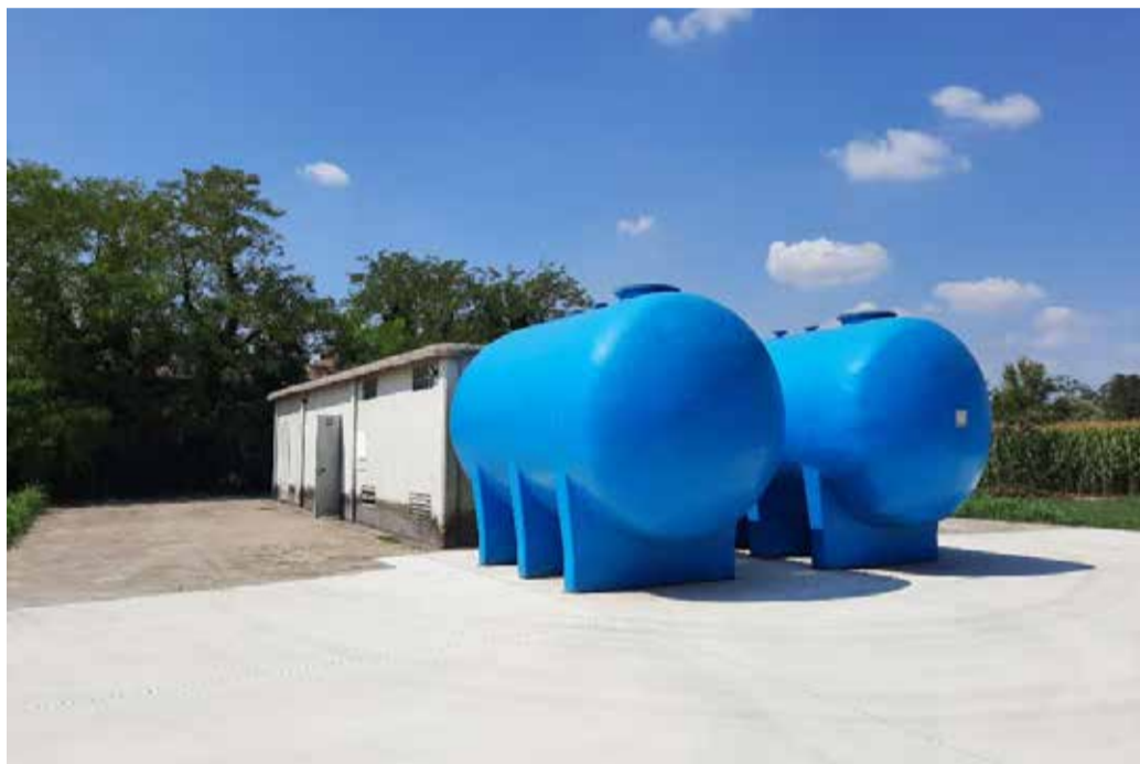
I lavori al pozzo di Boldeniga
